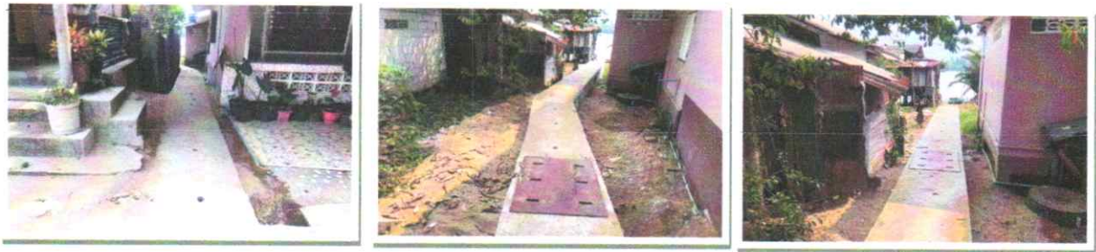
๑๐. โครงการก่อสร้างคูระบายน้ำพร้อมทางเดิน ซอยตรงข้ามมัสยิดเจ๊ะเท ชุมชนภัทรภักดี (งบประมาณ ๕๔๒,๐๐๐.-บาท)
