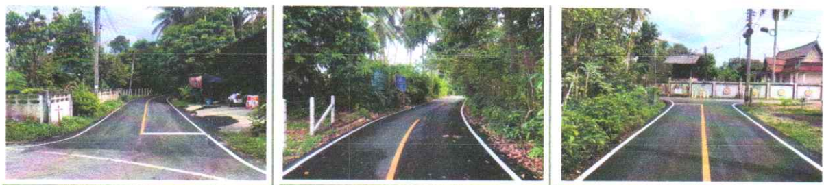
๒๕. โครงการก่อสร้างราวเหล็กกันตกบริเวณต้นทาง (ธนาคารออมสิน) ถนนใจกลางเมืองตากใบ (งบประมาณ ๖๘,๐๐๐.-บาท)
