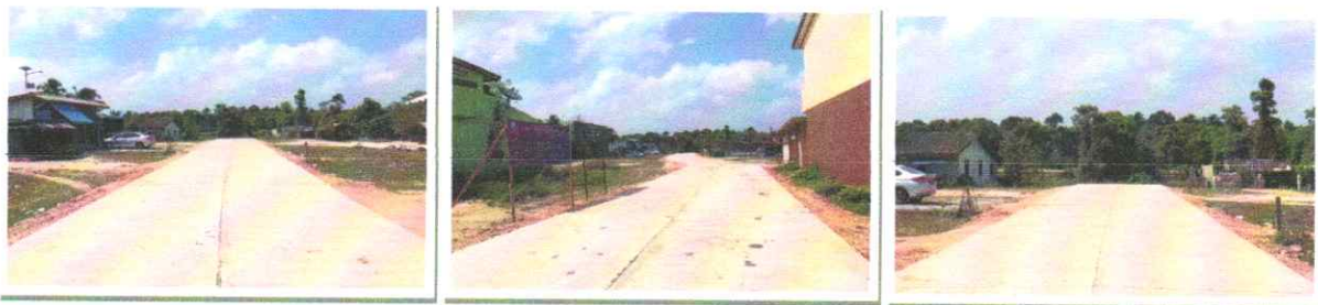
๒๔.โครงการเสริมผิวจราจรลาดยางแอสฟัลท์ติกคอนกรีต ถนนสายชลธารา – วัดบางน้อย ชุมชนบางน้อย (งบประมาณ ๓๗๒,๕๐๐.-บาท)
