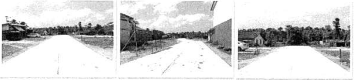
๒๔.โครงการเสริมผิวจราจรลาดยางแอสฟัลท์ติกคอนกรีต ถนนสายชลธารา - วัดบางน้อย ชุมชนบางน้อย (งบประมาณ ๓๗๒,๙๐๐.-บาท)
