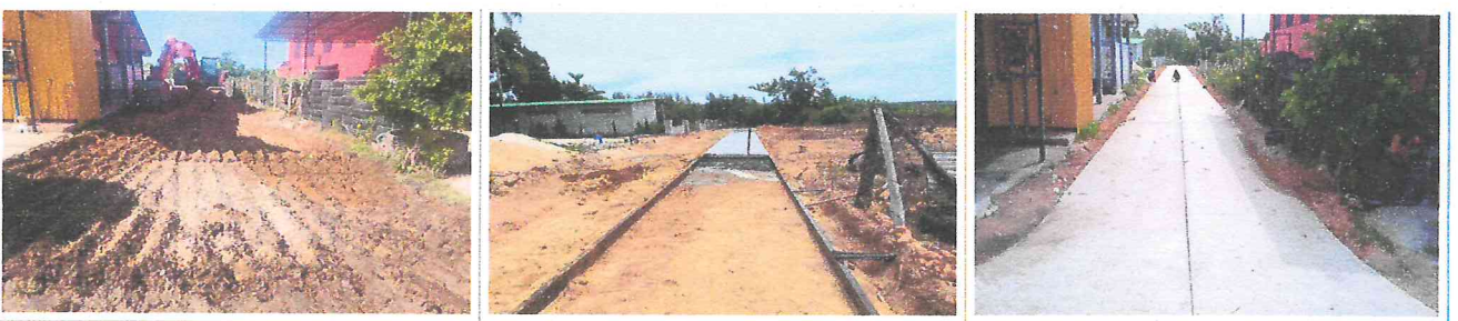
20.โครงการก่อสร้างถนน คสล. ซอยแยงะชุมชนสามัคคี งบประมาณ 258,300 บาท
