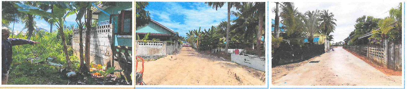
18.โครงการก่อสร้างถนน คสล. สายใจกลางเมืองตากใบ ซอย 1 ชุมชนตลาดตากใบ งบประมาณ 859,600 บาท
