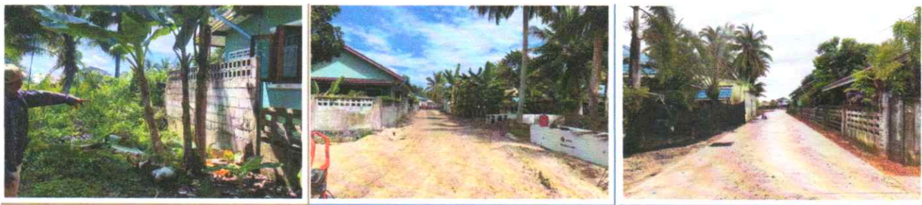
17.โครงการก่อสร้างถนน คสล. พร้อมระบายน้ำซอยตาบะต้อเยาะ 1 (ต่อจากเดิม) งบประมาณ 1,111,000 บาท
