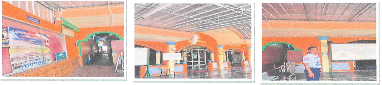
๗๐.โครงการติดตั้งกันสาดมัสยิดอิสฮานเฟส ๒ (เพิ่มเติม) (งบประมาณ ๑๕๐,๐๐๐.-บาท)
