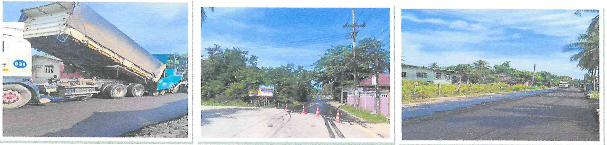
๒๒. โครงการเสริมผิวจราจรลาดยางแอสฟัลท์ติก ถนนสายปอเนาะเก่า ชุมชนฮ่อมลานีส (งบประมาณ ๗๖๘,๐๐๐.-บาท)
